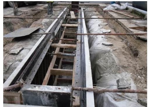
Figure 45. Bétonnage de la cuve de dépotage
