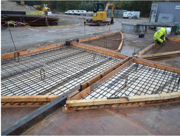
Figure 29. Préfabrication des prédalles
