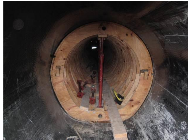
Figure 43. Aqueduc de La Vanne – Plaque ép. 8mm
