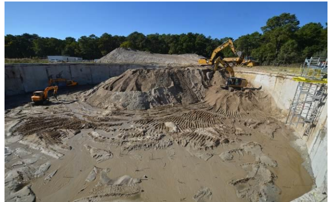
Figure 16. Réservoir en cours d'excavation
