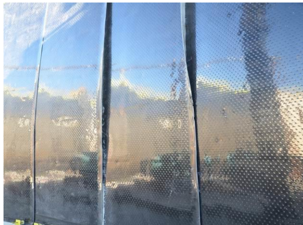
Figure 31. Vue des prémurs avant soudure
