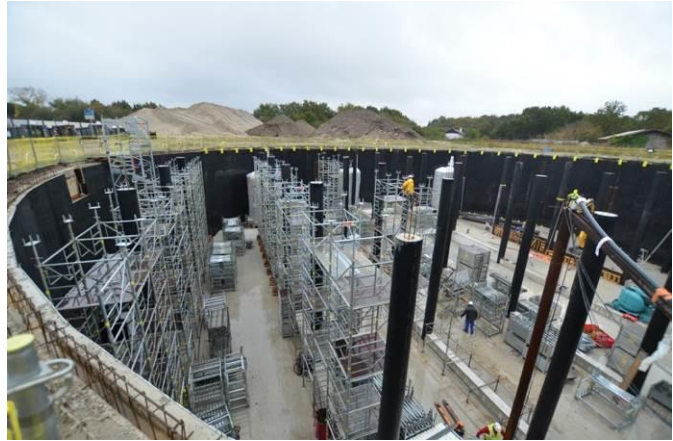
Figure 30. Échafaudage du plafond
