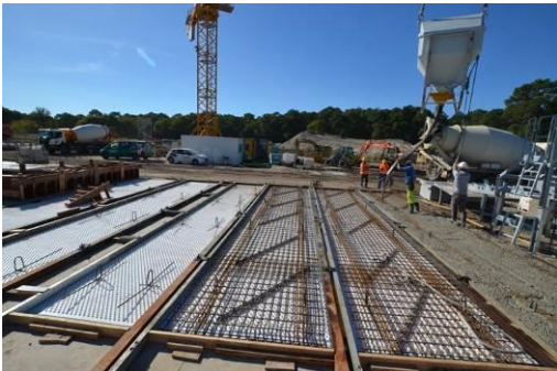
Figure 20. Aire de préfabrication des prémurs
