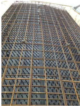
Figure 24. Pose de l'étanchéité sur le coffrage
