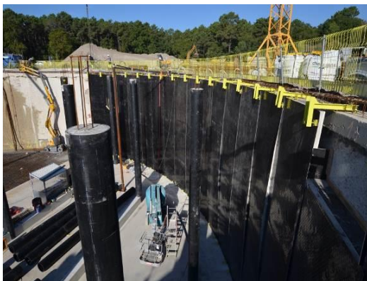
Figure 22. Vue des prémurs
