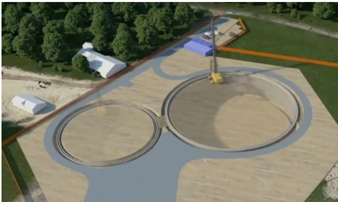
Figure 15. Paroi moulée des 2 ouvrages
