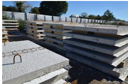
Figure 21. Stockage et séchage des prémurs
