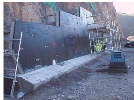
Figure 47. Étanchéité d'une paroi rocheuse
